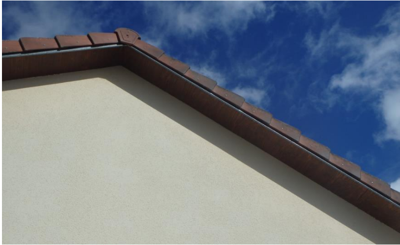
Photo 17: Tuile de rive
