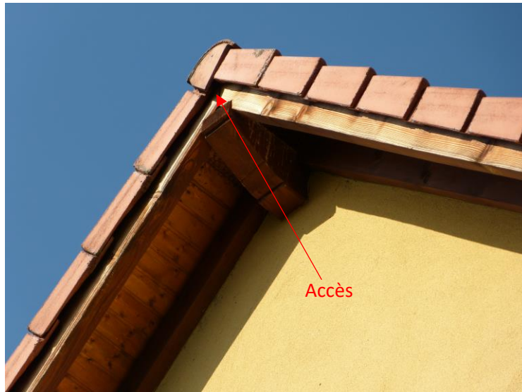
Photo 7 : Avancée de toiture
