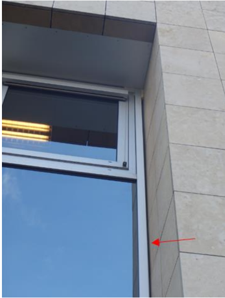
Photo 20 : Rebord de fenêtre en aluminium
