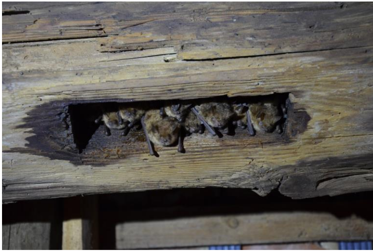
Photo 10 : Mortaise sous une poutre
