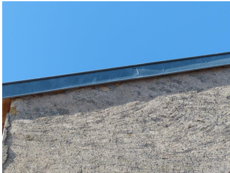
Photo 15 : Arase toit / mur
