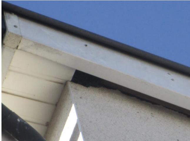
Photo 21 : Avancée de toiture
