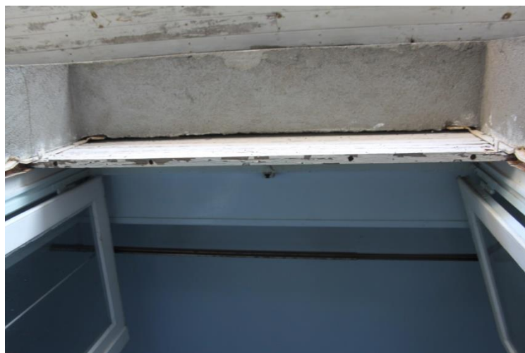
Photo 16 : Caisson de volet roulant
