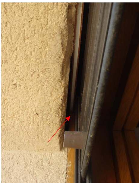
Photo 19 : Espacement entre volet et mur
