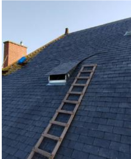
Photo 32 : Création d'une chiroptière au niveau d'une toiture
